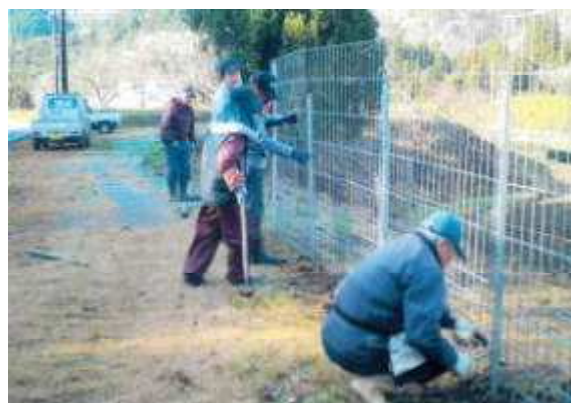
侵入防止柵の設置作業 (R1 新城市)
