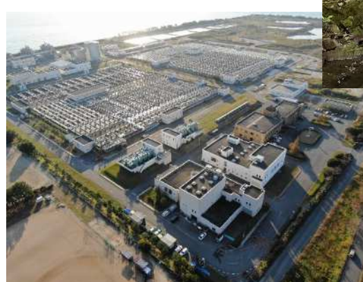
上工下水道施設(下水処理場)
