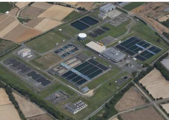
上工下水道施設(浄水場)
