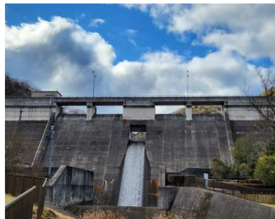
河川施設(ダム)
