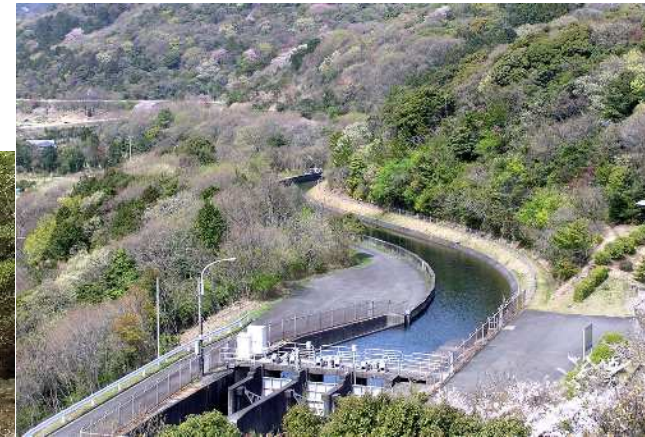
農業水利施設(農業用水路)
