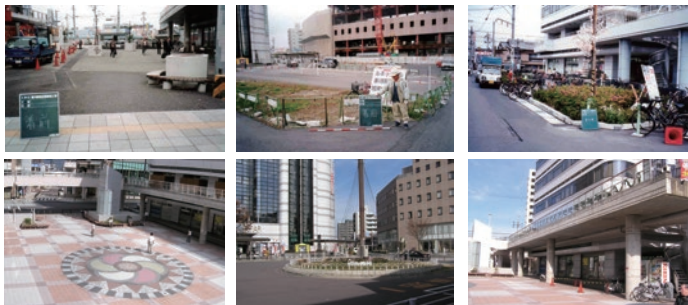
上：開発工事着手前と、下：工事完了後の様子。駅前公園、駅前広場、ペDESTリアンデッキなど総合的に再開発された。（写真提供：春日井市都市整備課）
