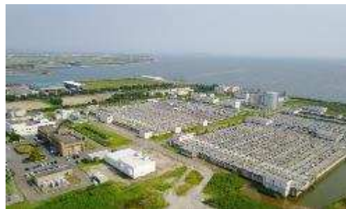
矢作川浄化センター
